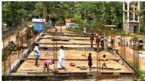
Darauf wird ein Sockel-Balken gelegt, der alle Säulen miteinander verbindet. Auf diesen Sockel-Balken kommen dann die 3,50 m hohen Mauern aus Ziegelsteinen und ein weiterer Sturzbalken. Auf diesen werden dann die letzten 1,50 m hohen Mauern aufgebaut und mit dem Dach aus Eisenbewehrtem Beton abgeschlossen. Sie sehen: Viel Arbeit! Die Kirche soll so schnell wie möglich genutzt werden können, sodass die feierliche Einweihung während unserer Indien-Reise im Herbst 2017 erfolgen kann.
