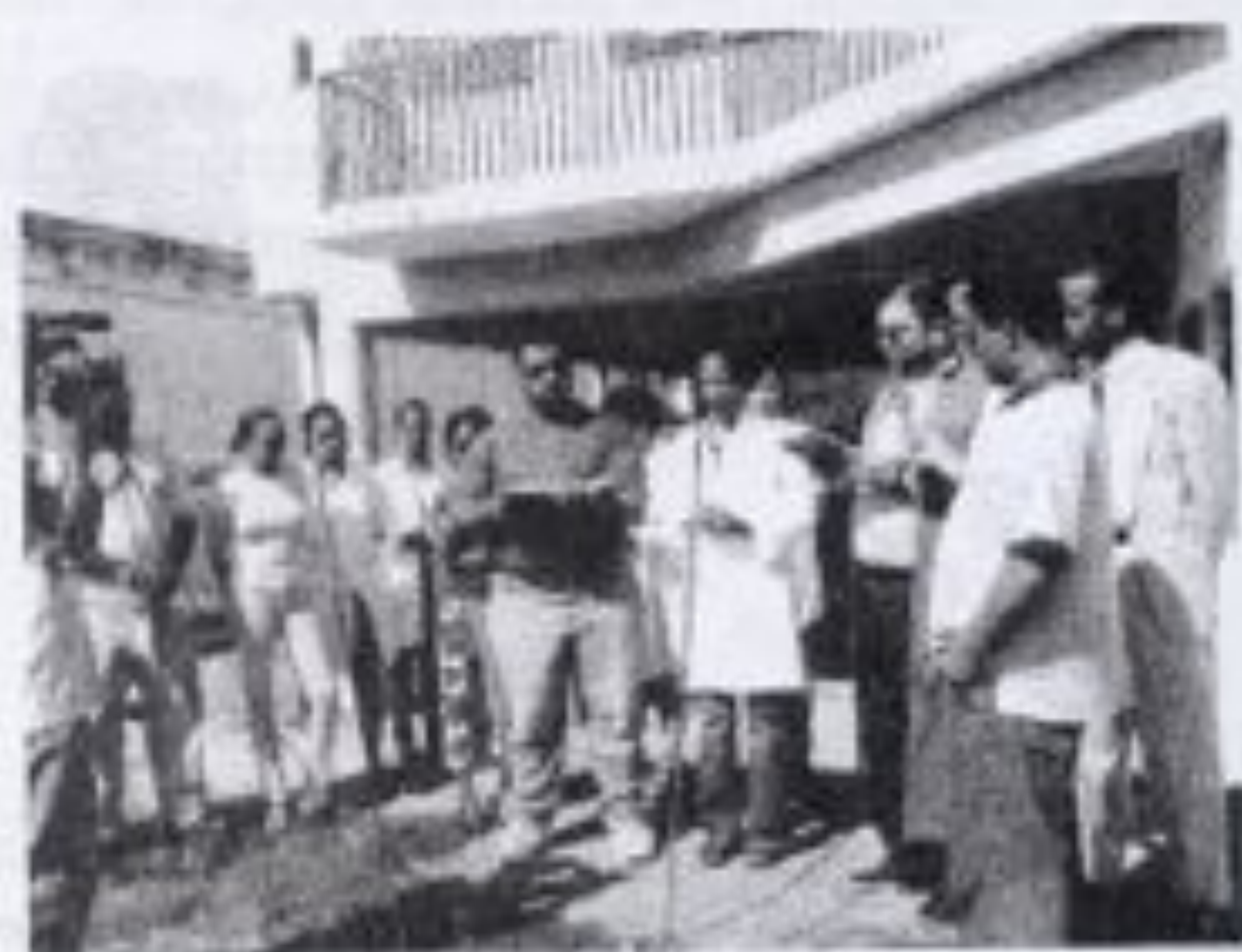
Einweihung des neuen Schulgebäudes
